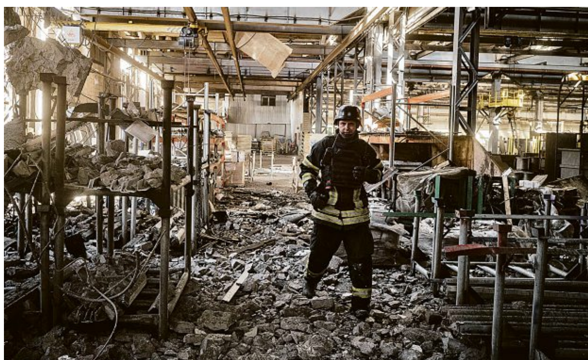
27. Mai 2024: Ein Feuerwehrmann inspiziert eine von russischen Bomben getroffene Landmaschinenfabrik in Charkiw. NICOLAS CLEUET/IMAGO
